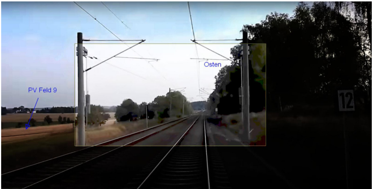
Bild 4.5.3: Foto am Messpunkt P5, Blick Richtung Osten (Quelle: Youtube Video tzMx0Q-e214 , Minute 27:00)
